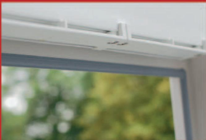
Die Außenluft wird über Blendrahmen-Einströmdichtungen an die Module geführt, dort dosiert weitergeleitet und gelangt über eine spezielle Flügel-Lüfter-Dichtung in den Raum.
